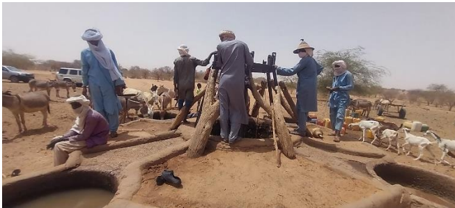
Photo 2 : Puits pastoral cimenté d'IKIZMAN de 125 m de profondeur et le seul dans la zone (région de Tahoua).
