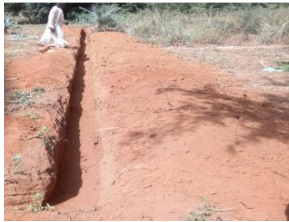
Image 15 : Fouille du réseau secondaire
