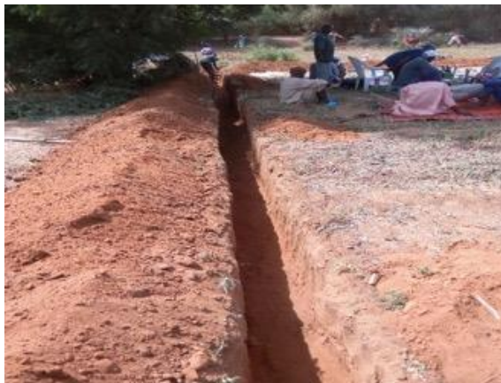
Image 14 : Fouille du réseau principal.
