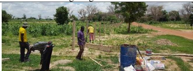
Clôture avec poteau en béton en cours de réalisation
