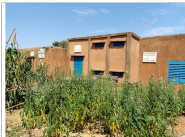
Le magasin de stockage de Garbey-Korou
