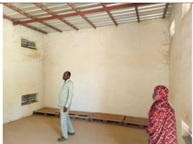
L'intérieur du magasin de Garbey-Korou
