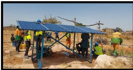
**Photo 7 : Installation des panneaux solaires.**
