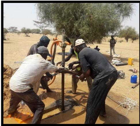
**Photo 3 : Réalisation d'un forage manuel pour capter les eaux souterraines.**
