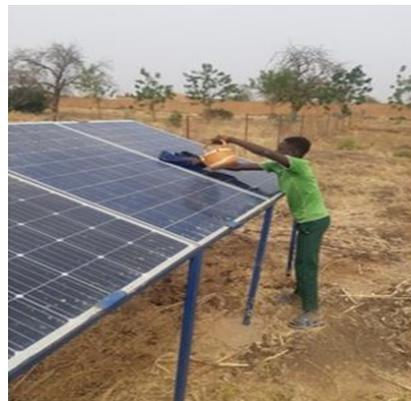
Photo 13 : nettoyage de panneaux solaires
