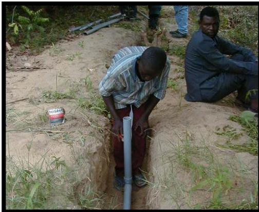
**Photo 5 : Installation du réseau californien par un plombier.**
