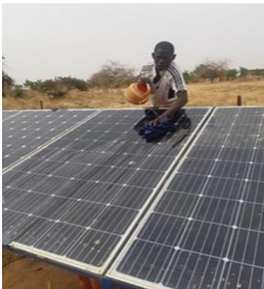
Photo 12 : nettoyage des panneaux solaires
