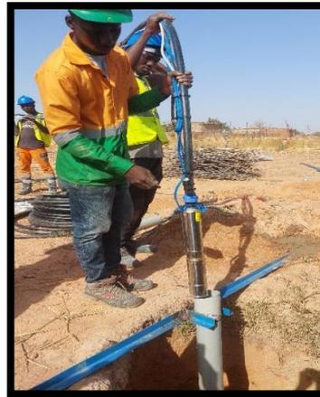
**Photo 4 : Installation d'une pompe immergée dans un puits.**
